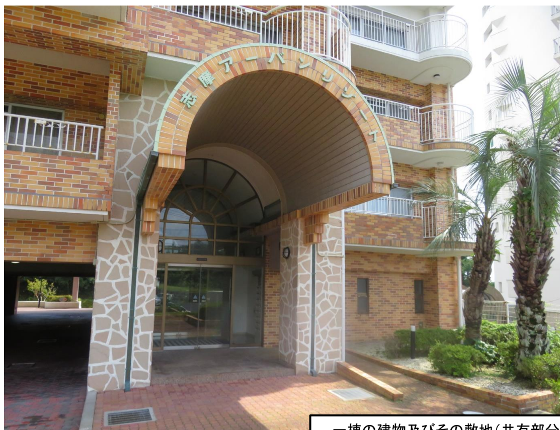
一棟の建物及びその敷地(共有部分)
